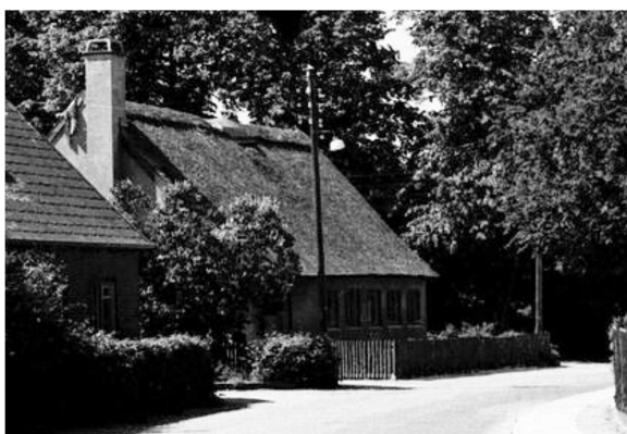
Huset i Vallensbæk efter istandsættelsen
