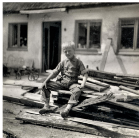
Simon på det nedrevne køkken i Vallensbæk
