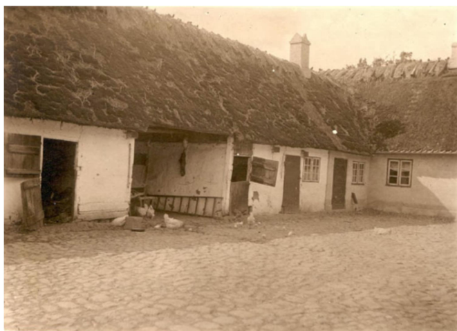
Denne gamle Valbygård (hvilken vides ikke) giver et godt billede af gårdene på den tid - bortset fra skorstenen som er nyere
